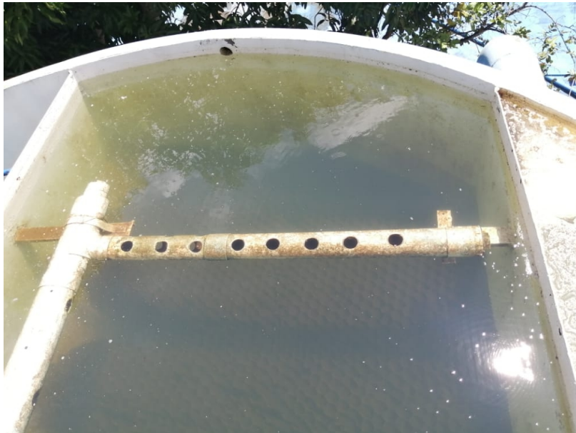
Ilustración 26. Floculación. Fuente: propia
