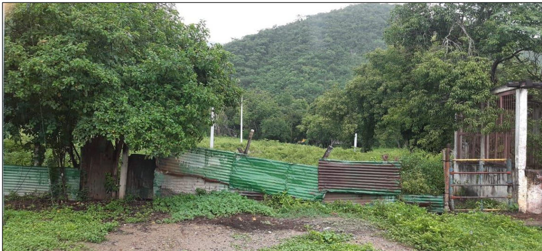
Ilustración 4: Entrada al predio, sobre la carrera séptima.
