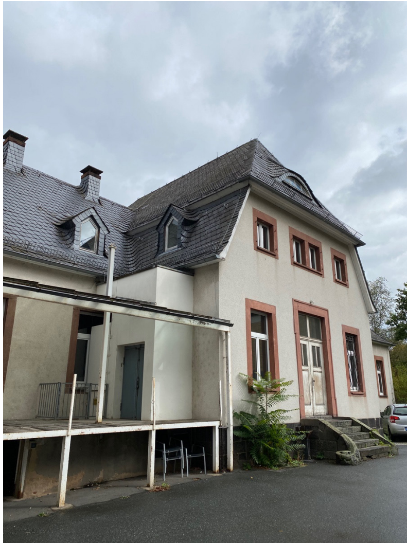
Abbildung 37: Die Alte Klinikapotheke in Gießen, Südseite, 2022. 213 Im Dachgeschoss lag die Dienstwohnung August Eberhards.
