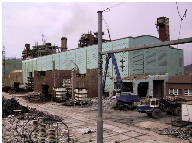
Figura 5. Fotografía de Escombreras I durante su demolición en 2003. Fuente: AHdI.
