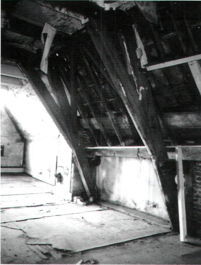
Afb. 10. Nieuwe Rijn 105 (kort na 1658), de kapconstructie van het voorhuis bestaat uit grenen dekbalkspanten (foto gemeente Leiden, M&A, E. Orsel)
