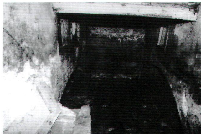
Afb. 15. Middelstegracht 143, de kelder onder het voorhuis. Het hoge deel (ter plaatse van de bedstede) heeft een houten zoldering. Onder de vloer van de voor- en achterraimte steken nissen met gewelfjes (foto Enderman, Bureau voor Bouwhistorie)
