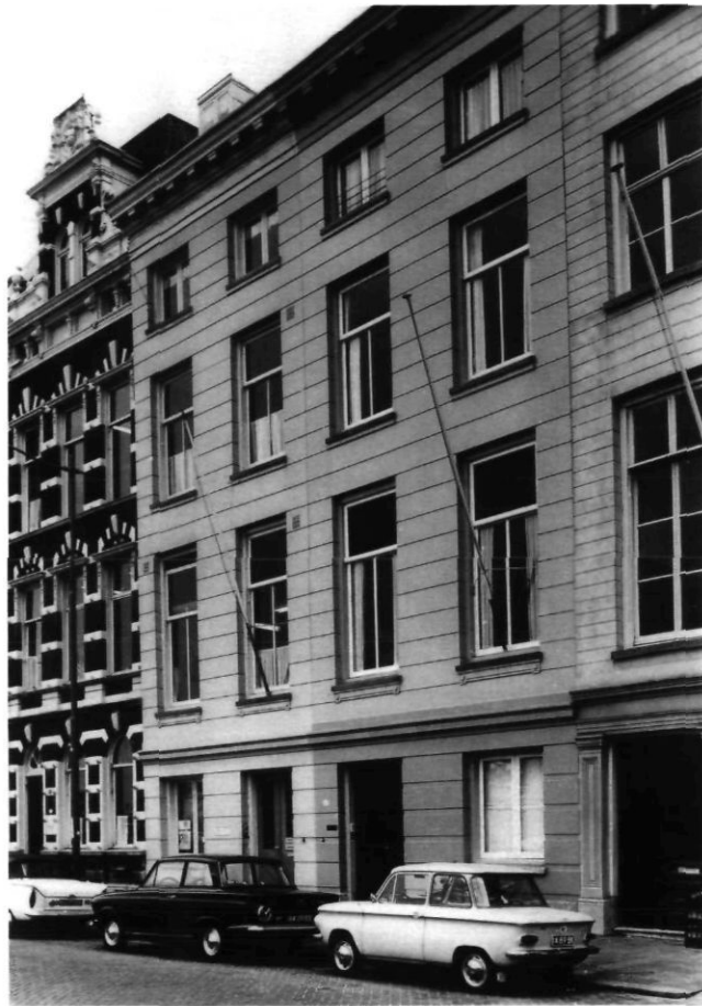
Afb. 24. No. 82, 84, 86. No. 82 tegen 1900 vernieuwd. Sluit inhoofdmaten aan bij ritme gevelwand. No. 84 en 86 is een tweelingpand met entreegang beneden (RDMZ).
