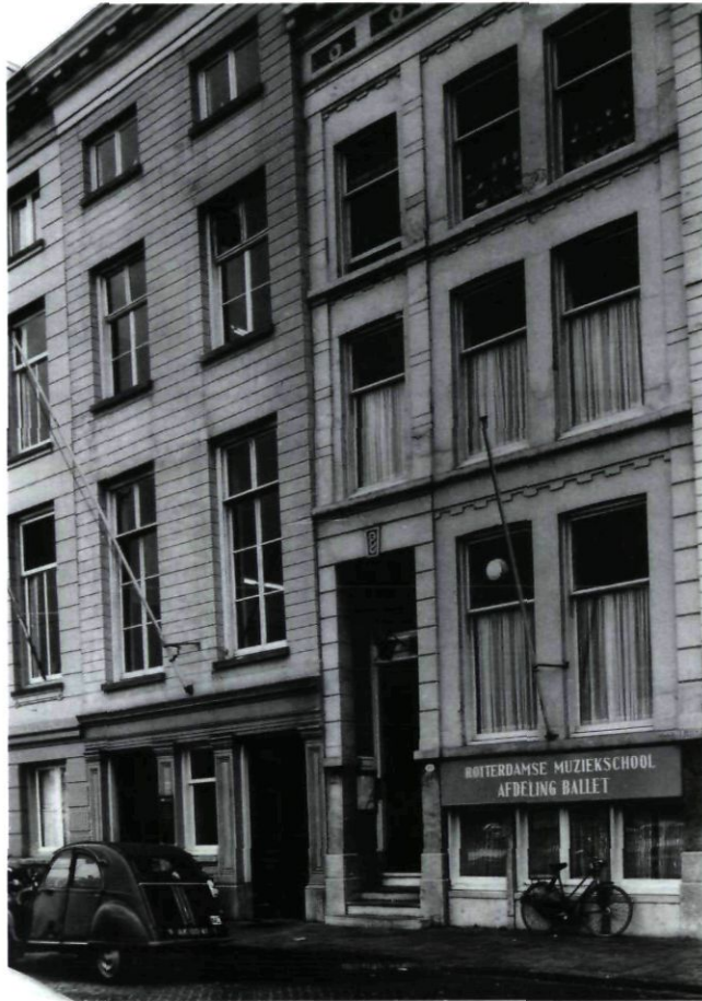
Afb. 25. No. 88 en 90. No. 88 heeft links de trap naar de hoge bel-etage en rechts naar het nog intacte magazijn, Klein kantoor tussenin. No. 90. De vroegere begane grond werd stoepverdieping met souterrain. (RDMZ 1968)
