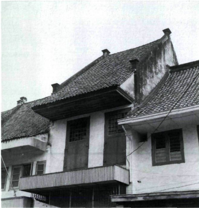
Afb. 12. De kleinere stadshuizen in het oude Batavia waren doorgaans twee lagen hoog en twee vensters breed. De nok lag evenwijdig aan de straat en er was een grote 'uitsteker' die bij hoge zonnestand de hele gevel beschaduwde (1972). Dit type is nu vrijwel geheel verdwenen.
