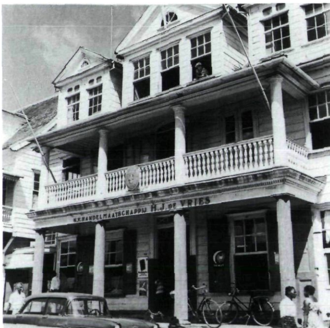
Afb. 2. Paramaribo, het mooie zakenpand Waterkant 92, tweede helft 19de eeuw (1962); afgebroken.
