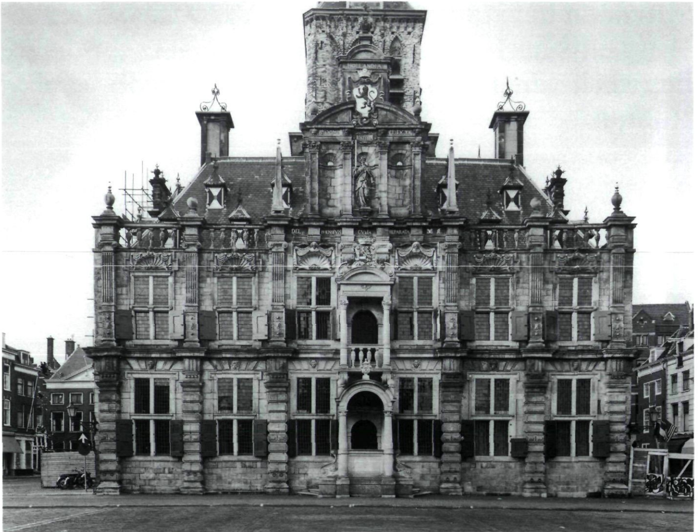
Afb. 2. Delft, Stadhuis, voorgevel. Foto Rijksdienst voor de Monumentenzorg Zeist 1966.
