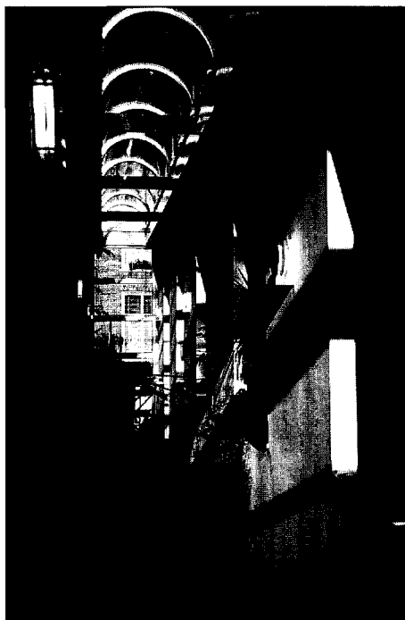
Afb. 24 Interieurfoto na de verbouwing. De steeg is als lichtstraat en trappenhuis herbouwd (foto BAD).
