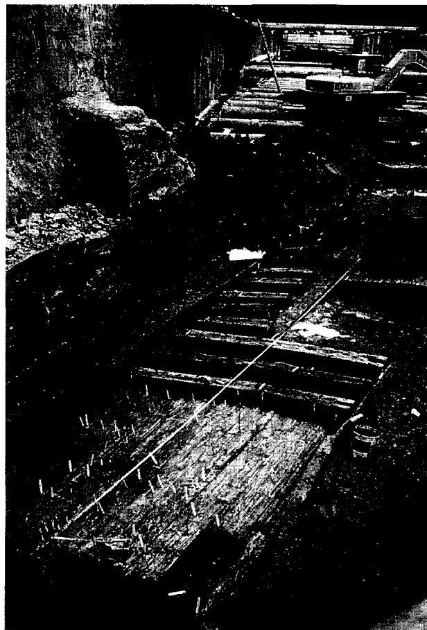
Afb. 2. De restanten van de bodem van een houten sluis (13de eeuw) in de bouwput. Rotterdam, Spoortunnel 1991, opgraving Bureau Oudheidkundig Onderzoek van Gemeentewerken Rotterdam (BOOR). Met dank aan dr. T. Guiran voor het bereidwillig ter beschikking stellen van de afbeelding. Foto: BOOR.
