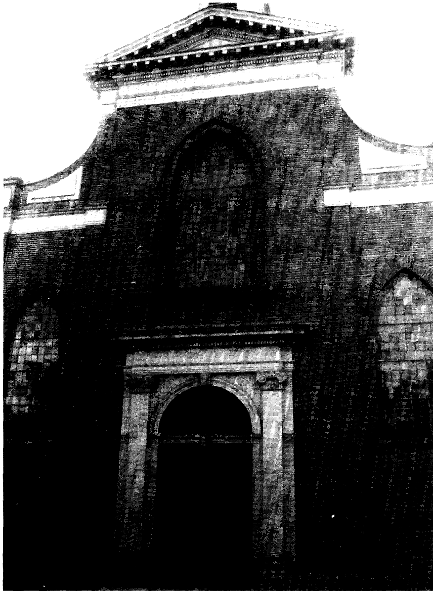
Alb. 12. Zaltbommel, St. Martinus, voorgevel, verbouwd 1838 naar ontwerp van E. Kroon, foto van de auteur 1986
