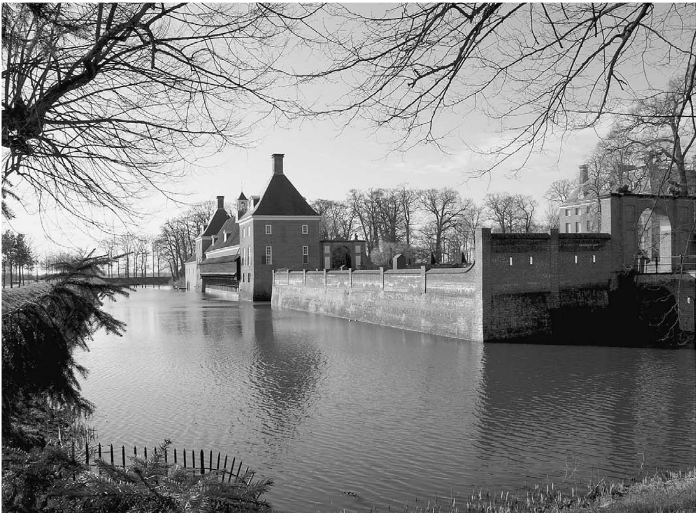
Afb. 15. De stallen en dienstgebouwen op de voorburch van Amerongen (foto Van Hoogevest Architecten)
