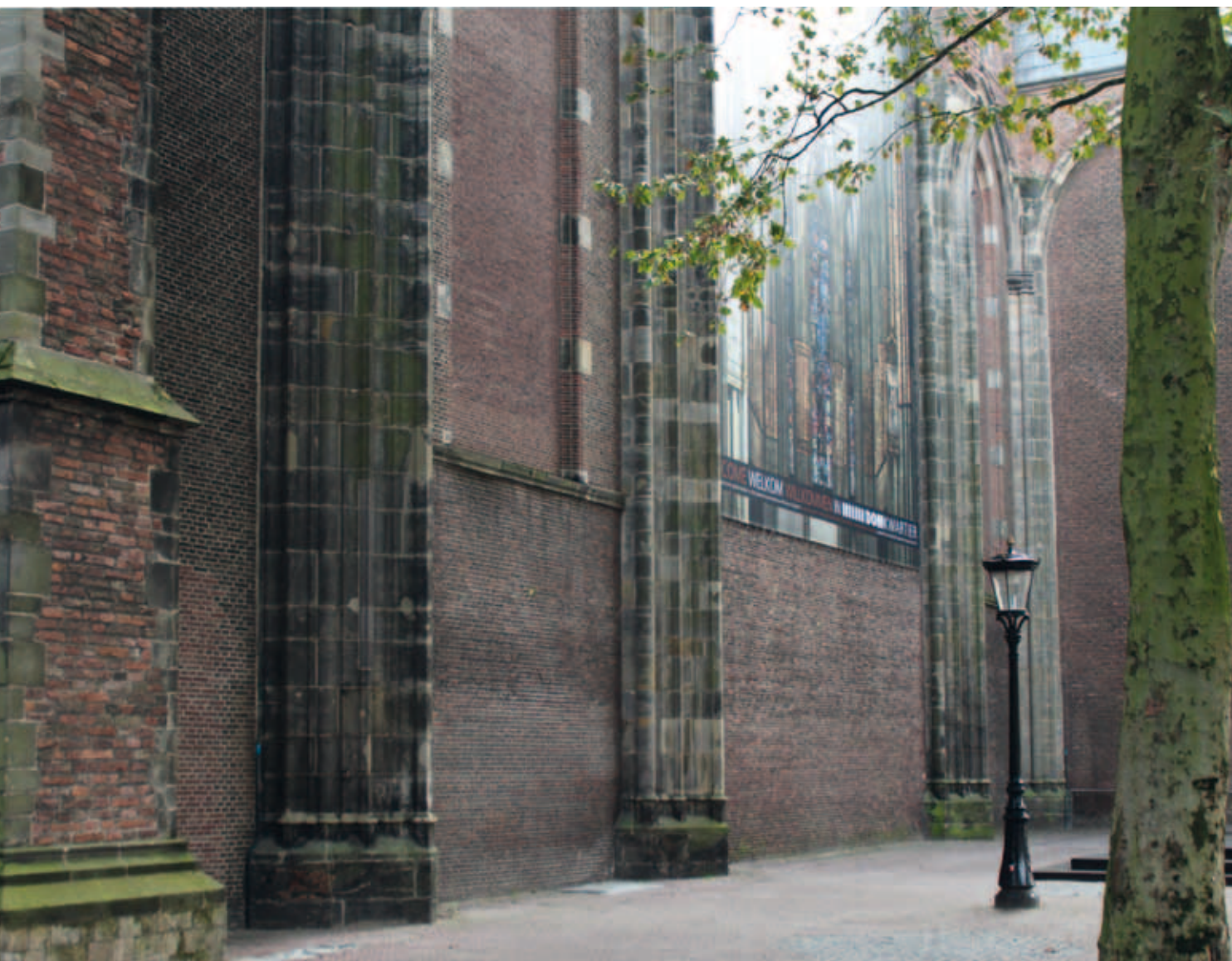
12. Westelijke transeptpijlers vanuit het noordwesten. Een deel van de pijlerblokken is kant-en-klaar in de groeve gehakt. Alle bogen zijn dichtgezet na de instorting van het schip in 1674 (foto auteur)
