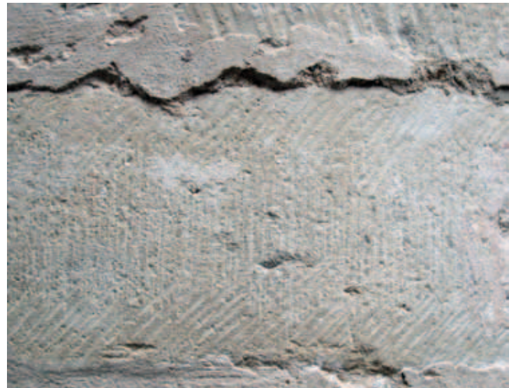
5. Fase IIa van de steenhouwchronologie voor witte kalkzandsteen op de westelijke halfzuil van het oude pastoorskoor. Op het middendeel van het gehouwen steenoppervlak komen verticale, scherp ingesneden parallelle lijnen voor. Deze zijn het resultaat van het gebruik van de steenbijl (zwaaiivlecht) of de polka. De randslag wordt gekenmerkt door ruwe, verder uit elkaar liggende streepjes. Deze zijn aangebracht met de beitel (foto Frans Doperé)
