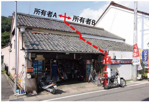
図7 鑿葺形式 棟分割の事例(本町 04)
