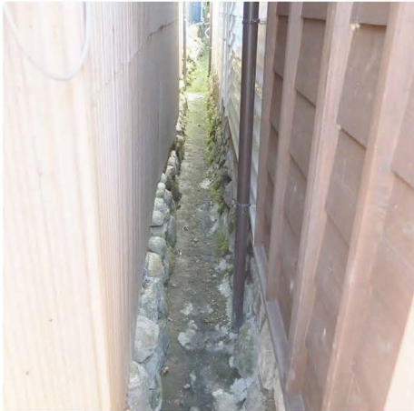
図11 本町北側での側溝の事例
