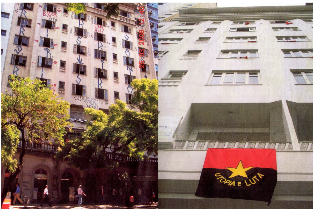
Figura 8 - Prédio do INSS restaurado para uso como Habitação Social. (Fonte: ecomeletrica.blogspot.com.br/2010/04/14-aguiar-engenharia-ltda.html )
