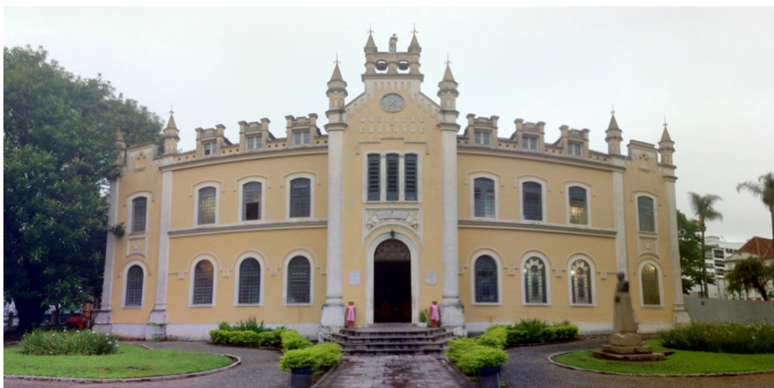
Figura 45 - Santa Casa de Misericórdia. (Fonte: Autor)
