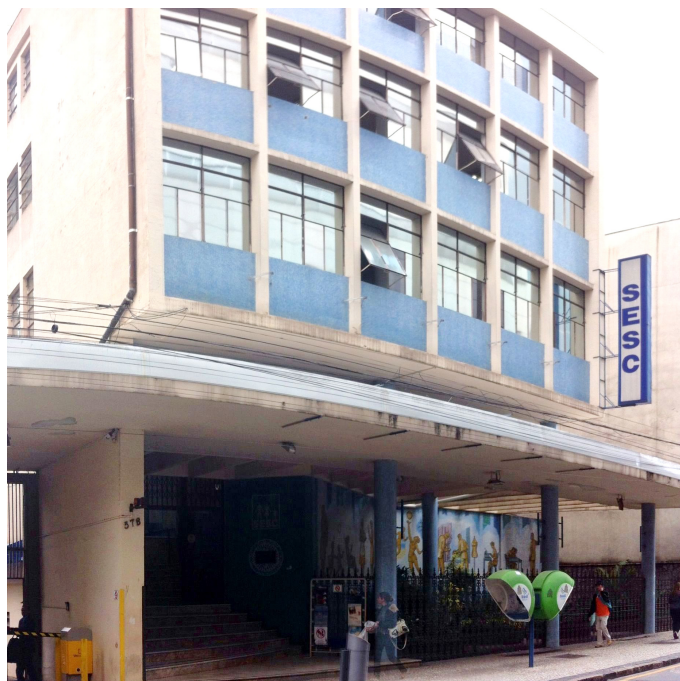
Figura 40 - Edifício do Sesc, na José Loureiro. (Fonte: autor)
