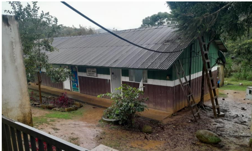
FIGURA 07 – Primeira Construção da Escola Indígena Mbyá Arandú
