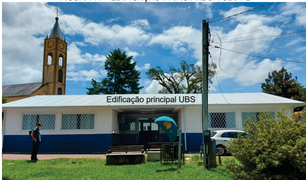
FIGURA 14 – EDIFICAÇÃO PRINCIPAL DA UBS P2
