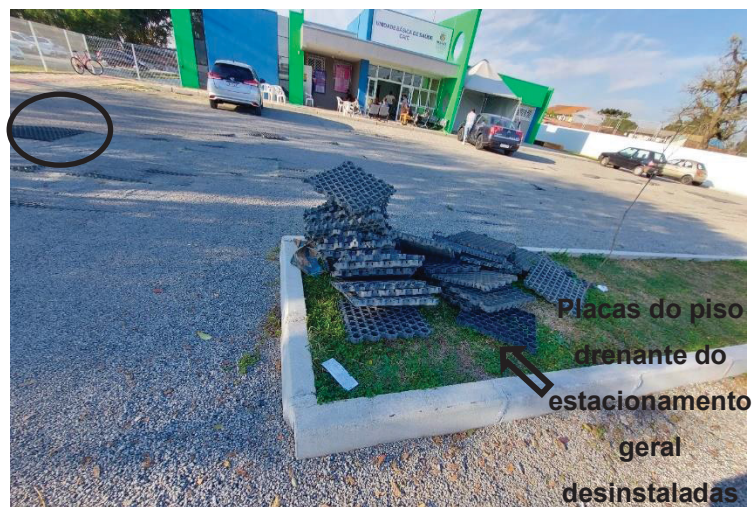
FIGURA 23 – REGISTRO FOTOGRÁFICO PISO DRENANTE ESTACIONAMENTO GERAL UBS P3
