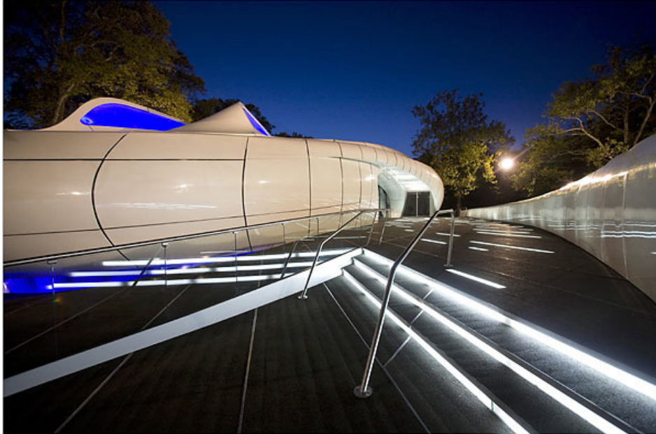
FIGURA 12: Foto do pavilhão montado no Central Park em Nova Iorque (FONTE: New York Times, 2008)
