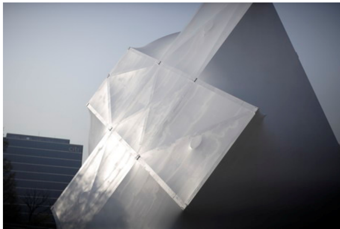
FIGURA 19: Foto da membrana utilizada como cobertura
