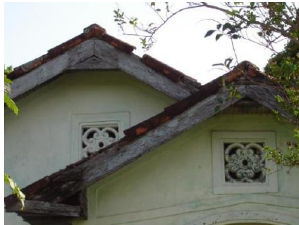
Figura 38 – Detalhe, Residência 01 FONTE: Paulo Ritter de Oliveira, 2008
