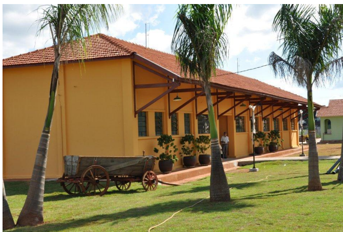
Figura 41 - Ferroviária restaurada FONTE: bibliotecacidadeaibipora
