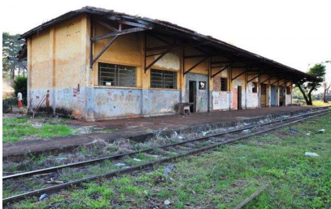
Figura 36 - Estação Ferroviária de Ibiporã FONTE: Prefeitura de Ibiporã
