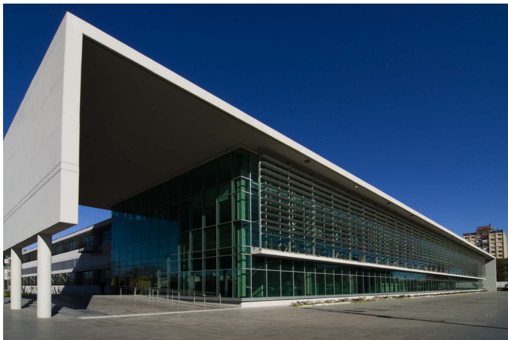
Figura 18 - Hospital Clemente Alvarez, acesso.
