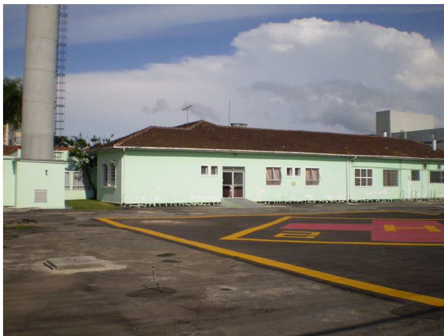
Figura 32 - Hospital São José, foto exterior 2.
