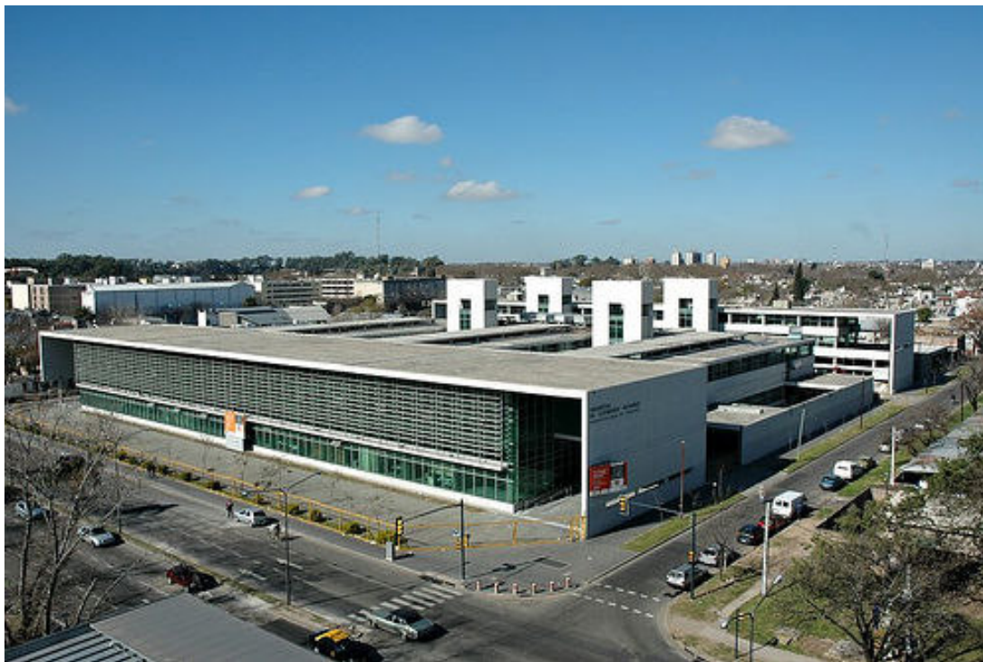
Figura 17 - Hospital Clemente Alvarez, sob avenida.
