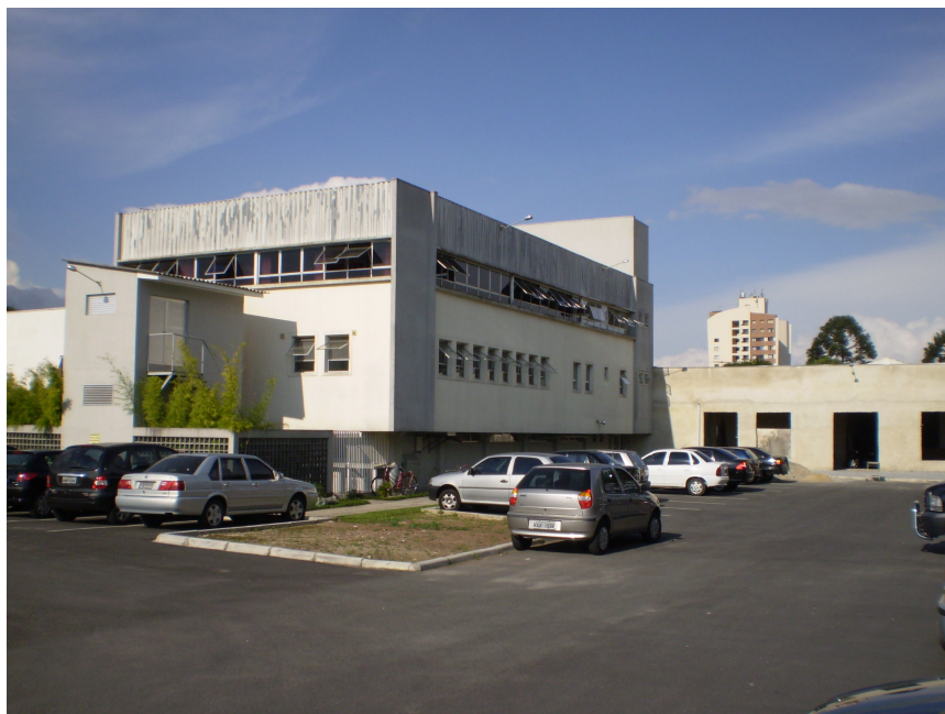
Figura 31 - Hospital São José, foto exterior.
