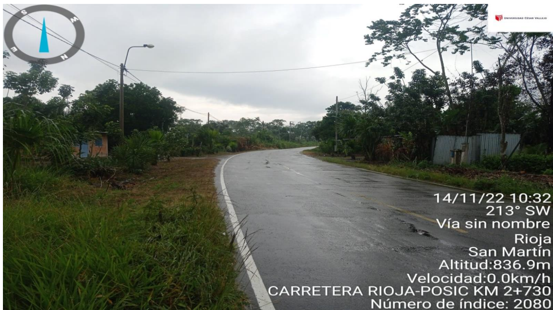
Figura 46: Vista del estado actual de tramo de carretera entre los pueblos vecinos Rioja – Posic KM 2+730
