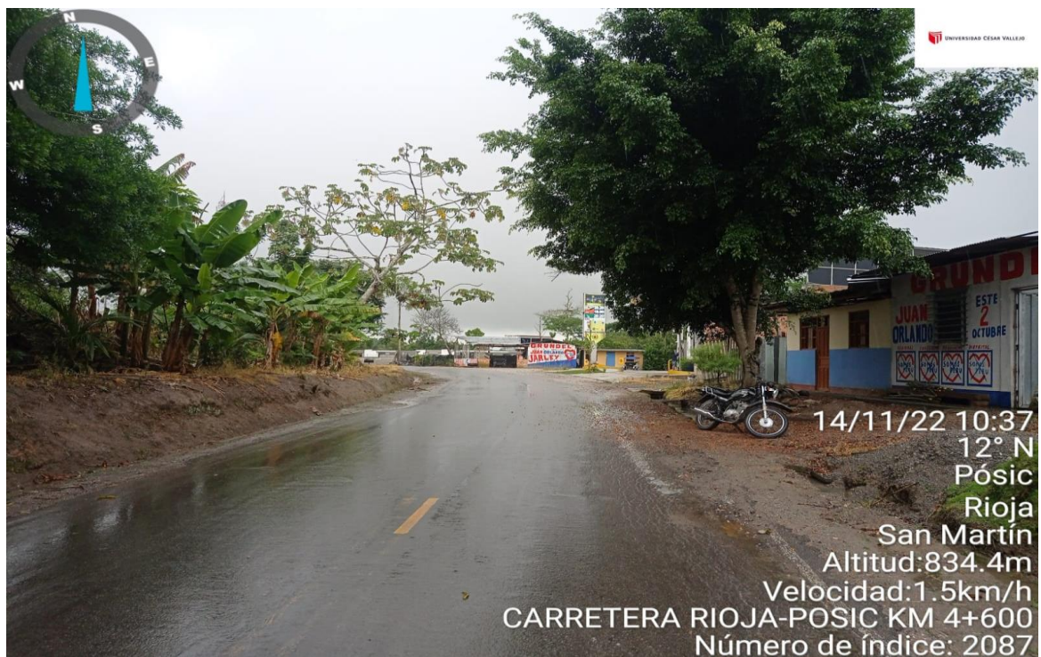
Figura 52: Vista del estado actual de tramo de carretera entre los pueblos vecinos Rioja – Posic -Tambo KM 4+600 – Dirección a Tambo
