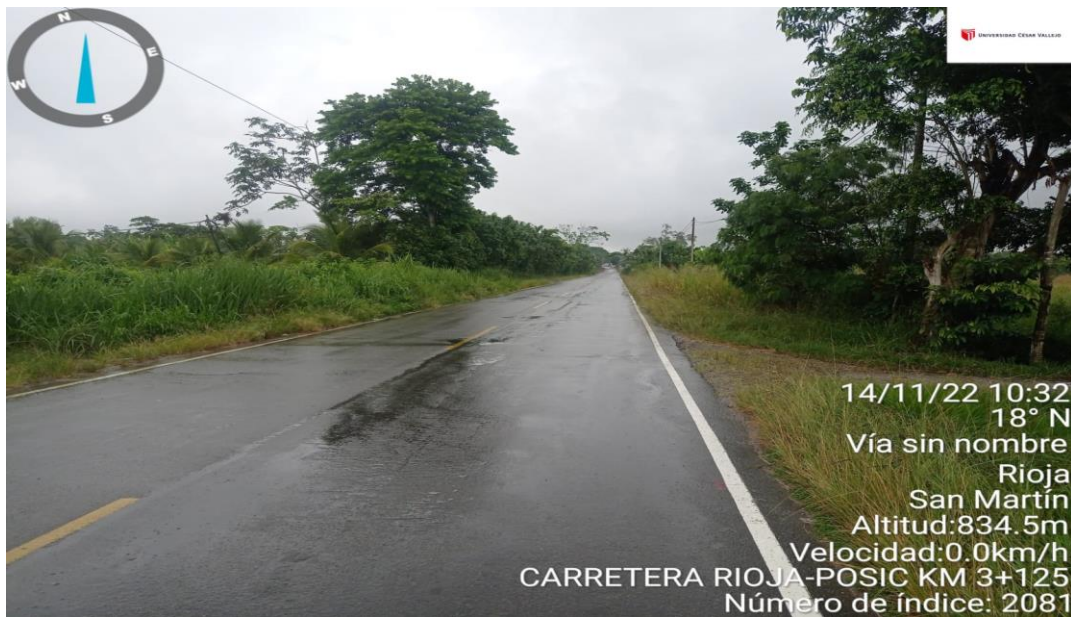
Figura 48: Vista del estado actual de tramo de carretera entre los pueblos vecinos Rioja – Posic KM 3+125
