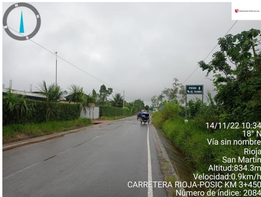
Figura 33. Vista del tramo de carretera dirección Posic -Tambo
