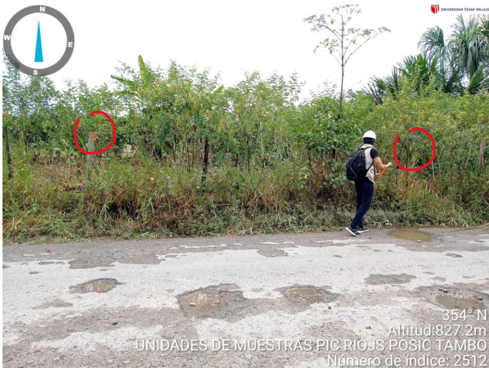
Figura 36. Vista del tramo de carretera dirección Rioja - Posic -Tambo
