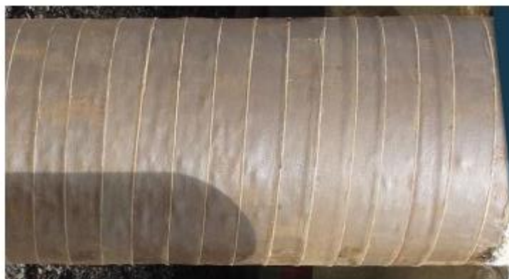
Figura 9:Aplicación del Marine Pile Protection Tape
