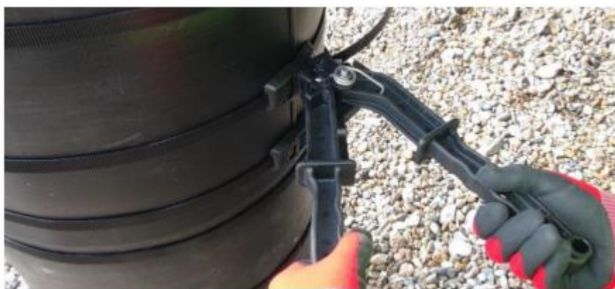
Figura 11: Instalación de zunchos de plástico para asegurar chaquetas.
