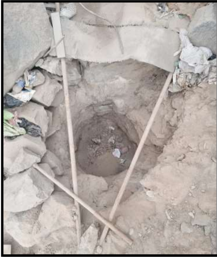
Figura N°105. Calicata. Fuente: Elaboración propia
