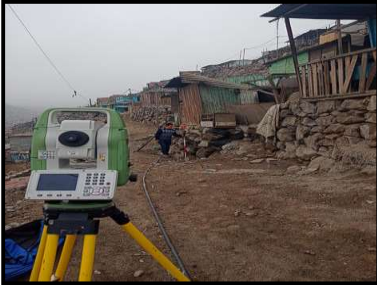
Figura N°99. Levantamiento con estación total.
