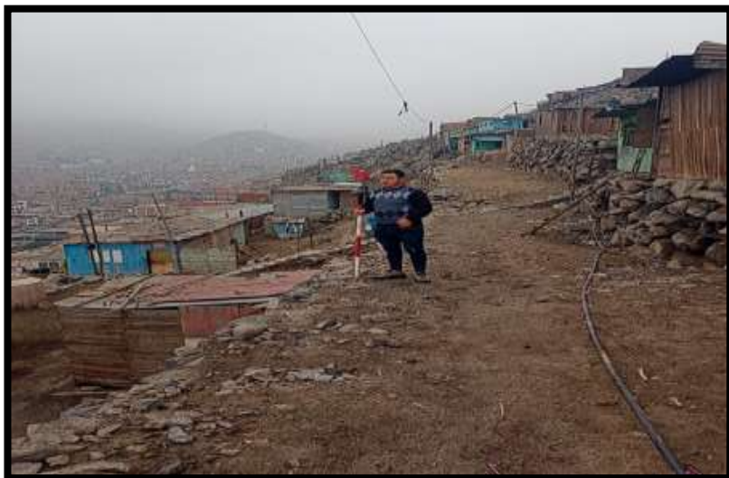
Figura N°100. Levantamiento con prisma.
