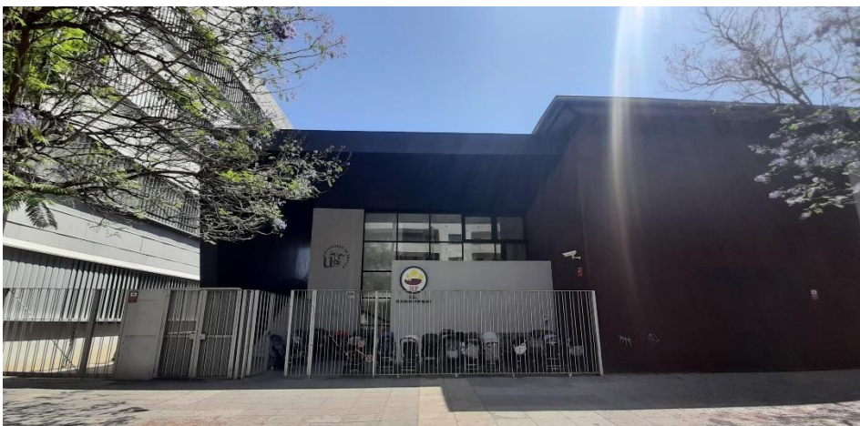
Figura 4: Fachada principal. Fuente: Propia
