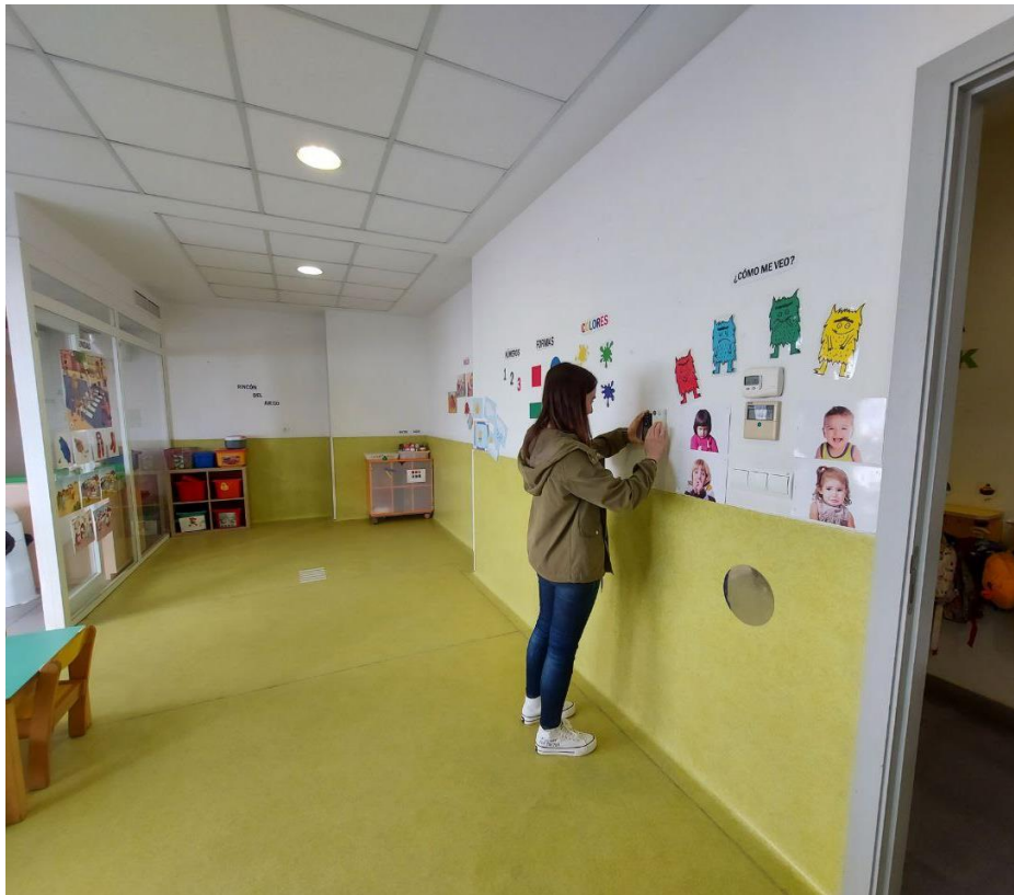
Figura 23: Instalación de sensores Testo. Fuente: Ignacio Acosta
