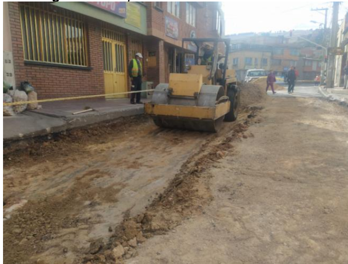
Figura 9. Compactación fondo de excavación.
