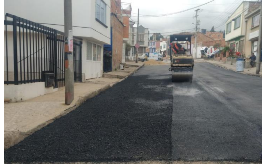
Figura 13. Compactación de la mezcla asfáltica.
