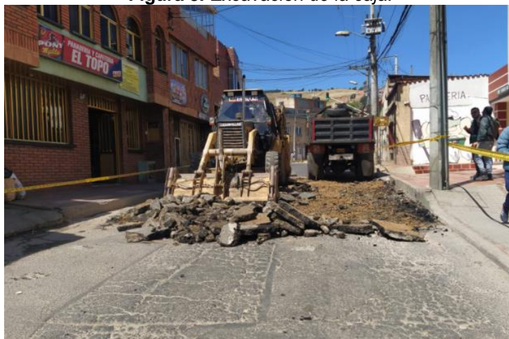
Figura 8. Excavación de la caja.
