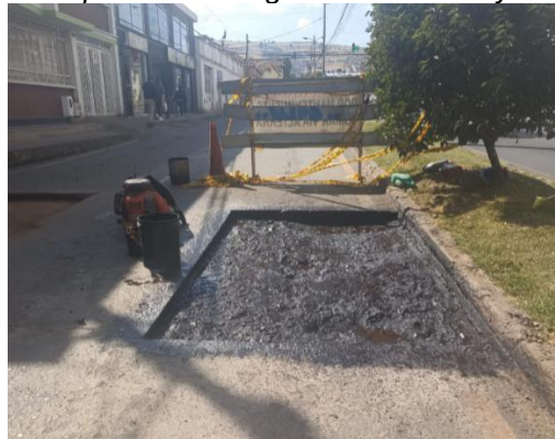
Figura 11. Aplicación del ligante bituminoso y emulsión asfáltica.
