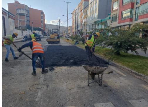
Figura 12. Extensión de la mezcla asfáltica.
