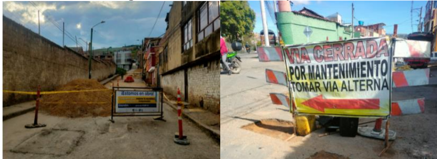
Figura 6. Control de tránsito y señalización.
