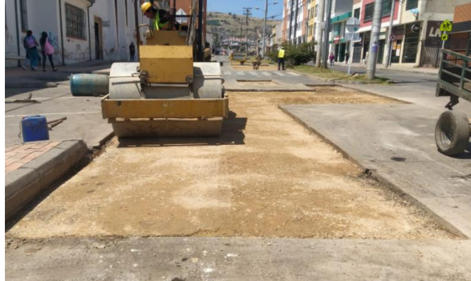
Figura 10. Preparación superficie existente.
