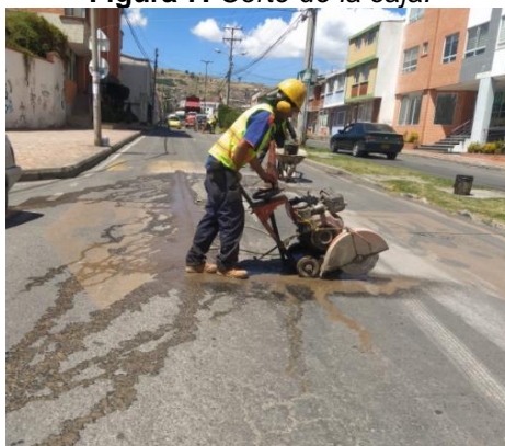
Figura 7. Corte de la caja.
