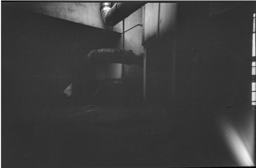
Figura 64 Fotografia realizada na fase final da FCT (projeto fotográfico).
