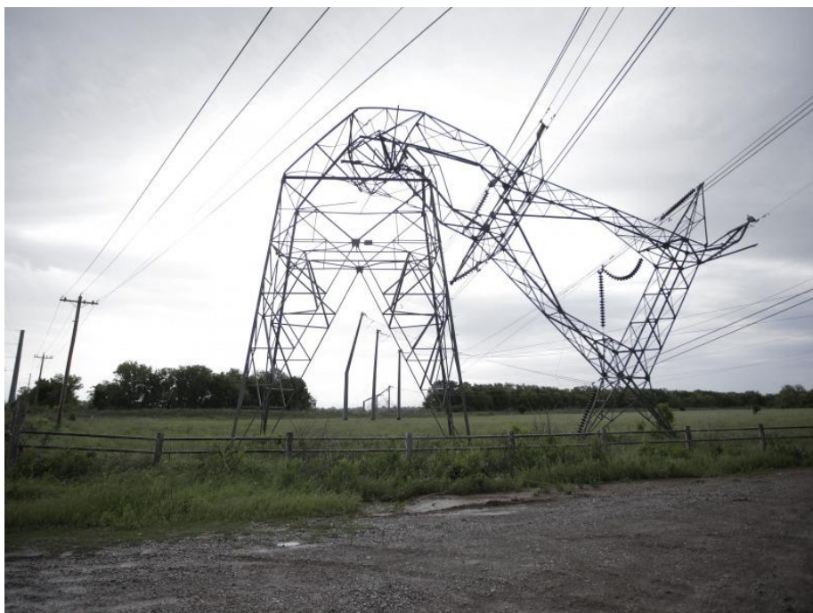
Figura 4 - Acidente em Apoio Reticulado [13].
