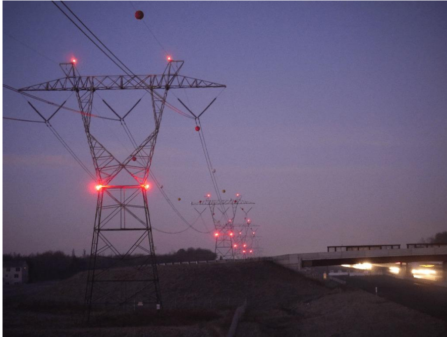
Figura 16 - Balizores e esferas presentes nos apoios [32].
