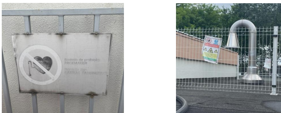
Figura 46 - Simbologia presente na zona adjacente ao teto da sala do scanner Philips
