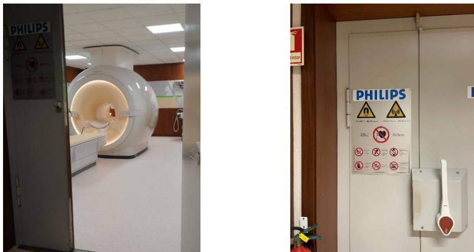
Figura 44 – Na imagem da esquerda visualiza-se o interior da sala do scanner da Philips e na imagem da direita visualiza-se a simbologia presente na porta de acesso à sala
