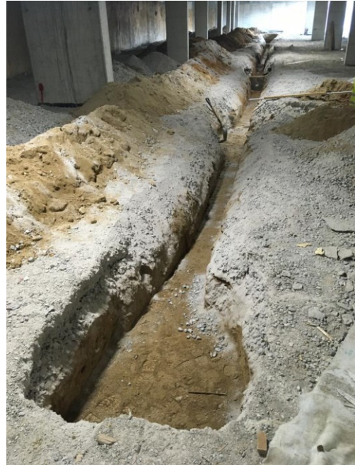
Abertura de vala para execução de rede enterrada. Note-se o negativo na viga de fundação.
