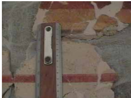
sl. 3. Nivelisanje fragmenata u pesku, pre nanošenja maltera
