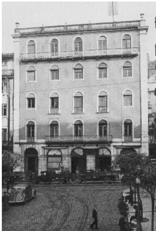
Fig. 1 – O edifício onde funcionou o Hotel Pelicano, quando ali estava sediada a Companhia de Papel do Prado, depois de 1922.
