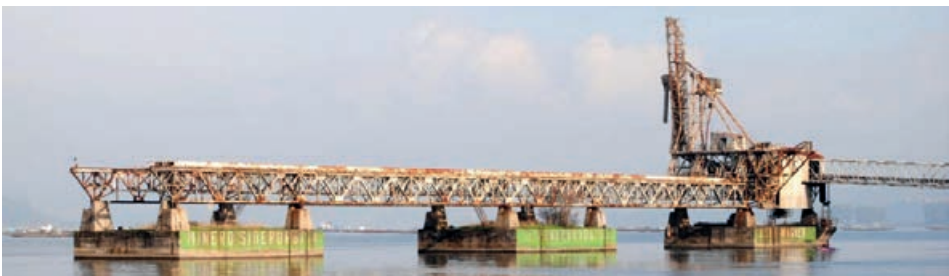
Figura 5. Cargadero de Coto Wagner (Redondela)
