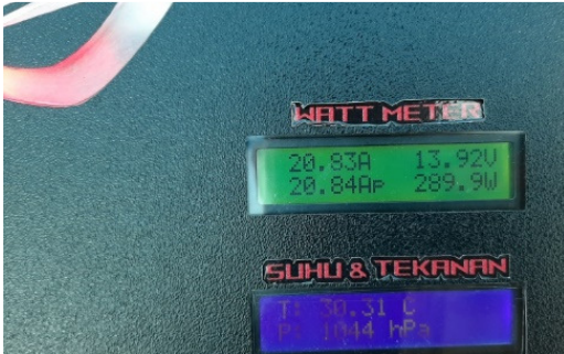
Gambar 13. Proses pengukuran tekanan dan suhu menggunakan sensor DS18B20 dan BM180
