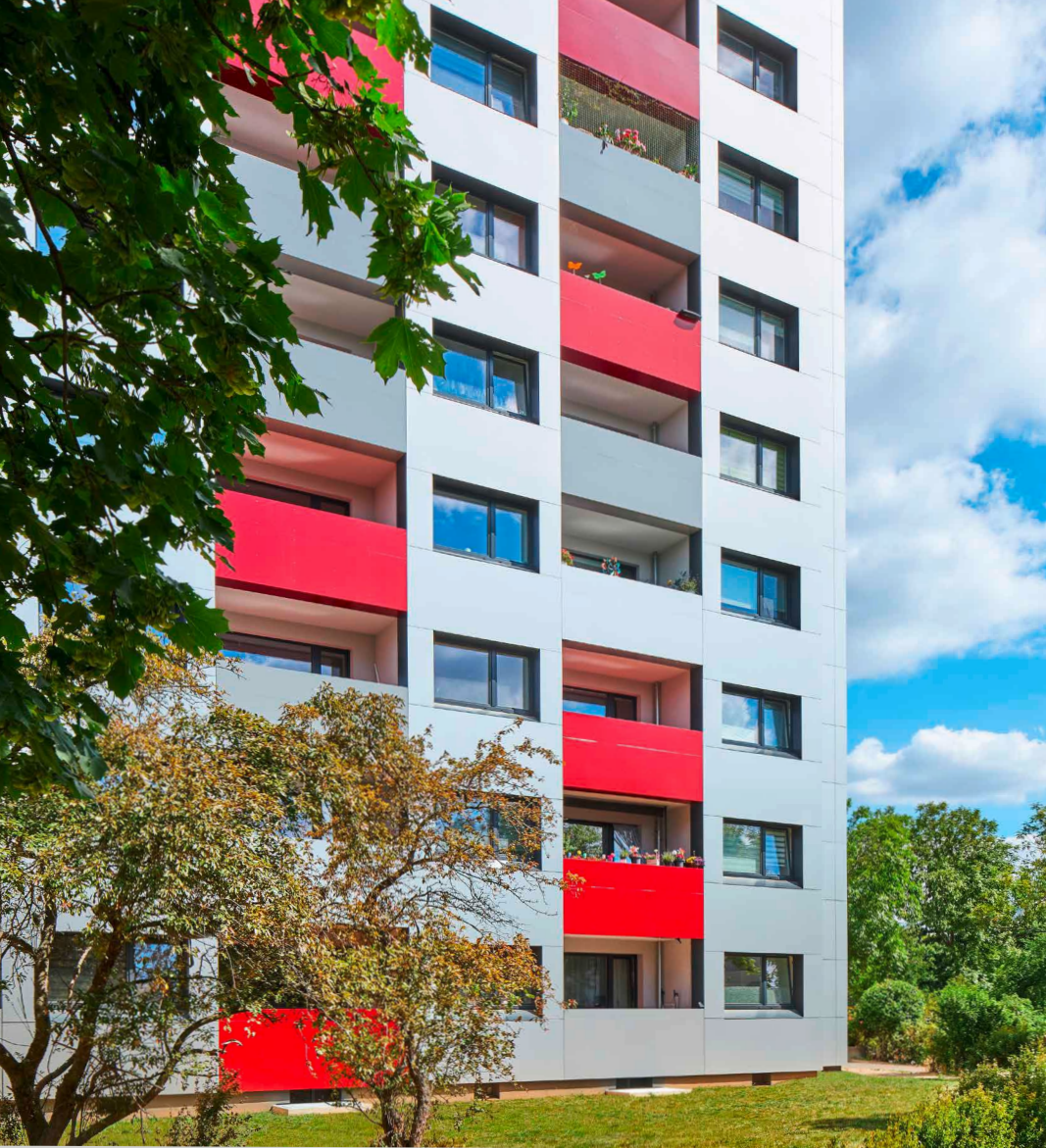
Saniertes Hochhaus in der Berliner Gropiusstadt
