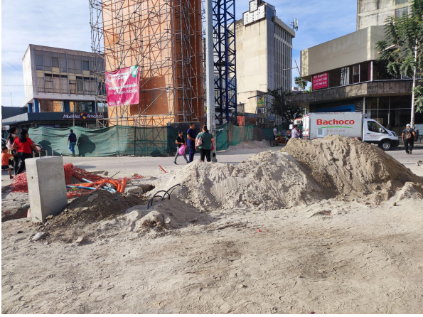
Figura 25. Estado de las obras sobre Av. 16 de Septiembre. Vista hacia el Norte desde el cruce con Leandro Valle.
