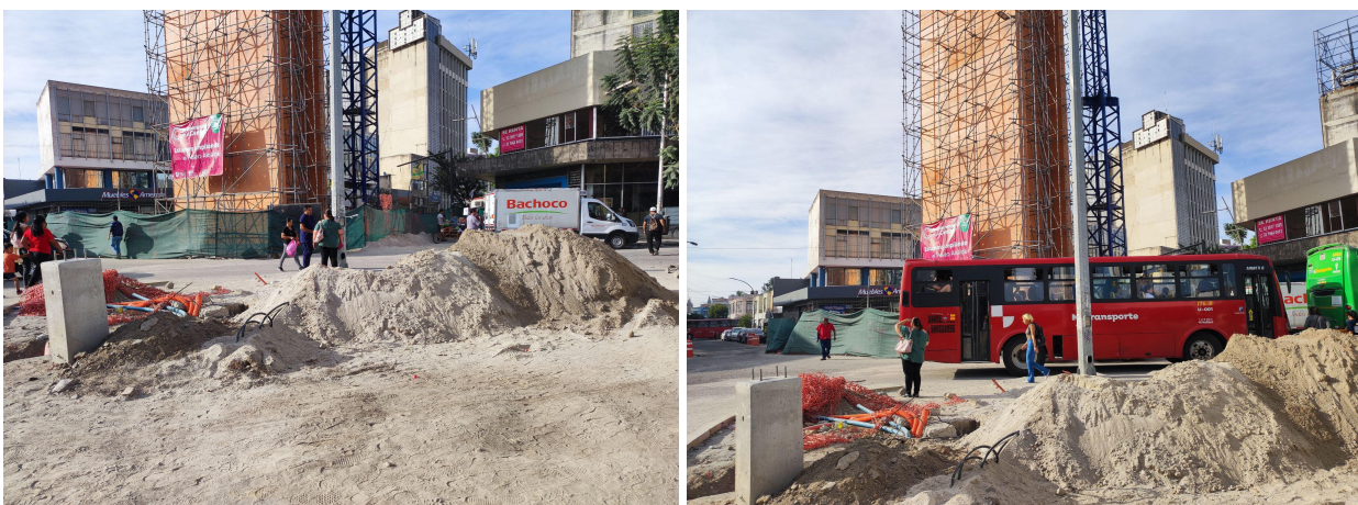
Figuras 8 y 9. Estado de las obras sobre Av. 16 de Septiembre a la altura de la calle leandro Valle
