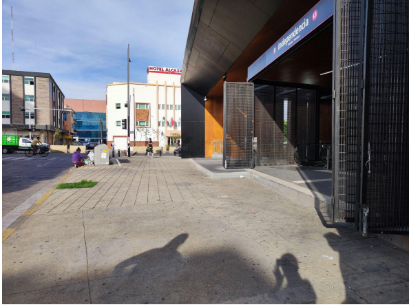
Figura 31. Salida de la estación Independencia por la Calle San Fernando.
