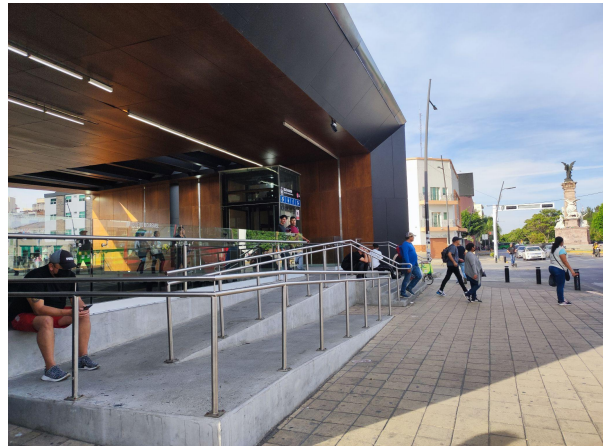
Figura 30. Salida de la estación Independencia de la Línea 3 por la calzada Independencia.
