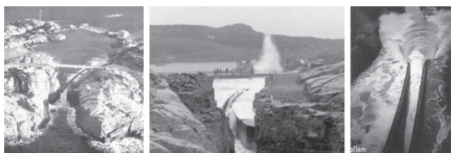
Figura 16 – A central de Toftestallen – canal convergente.
