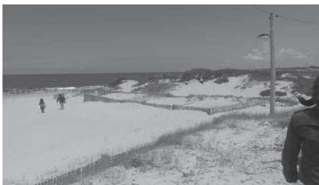
Figura 4 – Medida de ordenamento adoptada para manutenção da retenção de areias, colocação de estacas. Fonte: Execução própria
