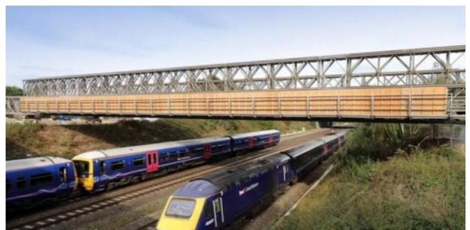
Figura 5- Utilização de painéis sobrepostos no Reino Unido, adaptado de Mabey Bridge 2020
