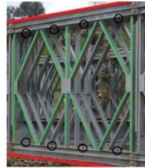
Figura 7. Reforços/alterações representadas num painel-tipo
