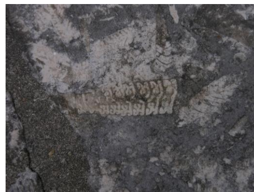
Pormenor do rebordo da cisterna: blocos de calcário com com Nerinea cf. olisiponensis (em secção) do Cenomaniano, Cretácico superior.
