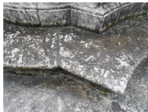
Pormenor do rebordo da cisterna: blocos de calcário com gastrópodes ( Nerinea ) do Cenomaniano, Cretácico superior.
