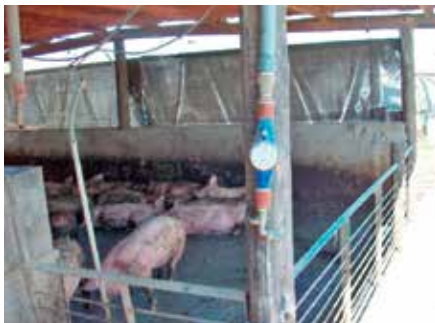
Foto 1. Medidor volumétrico conectado al grifo utilizado para el lavado de corrales de cerdos.
