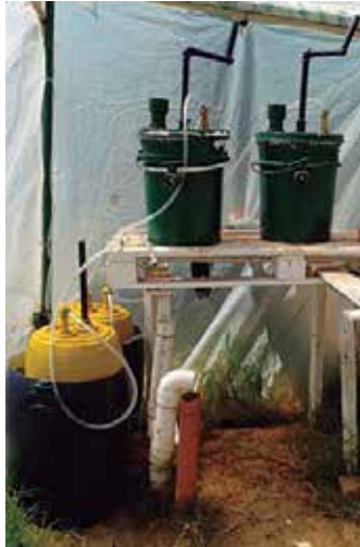
foto 7: Digestores construidos según lo expuesto por el Ing. Orlando Giampaoli, en "El camino de la biodigestión".
