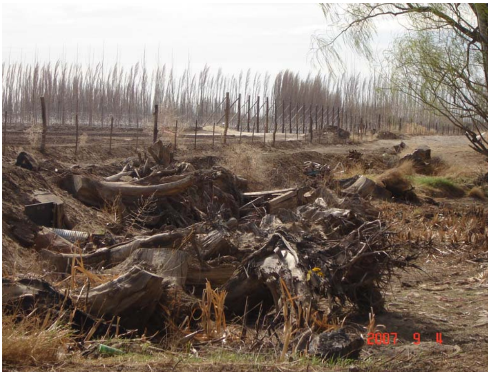
Las fotos muestran una zona de antigua laguna rellenada y nivelada para comenzar la plantación y riego (Cifuentes e Hijos).
