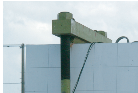
(b) 支点部跳ね上がり防止用押さえ金具
