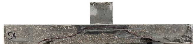
(d) Crack patterns of S4
