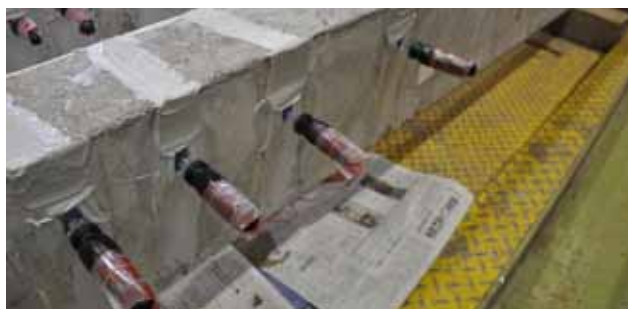
(d) Injecting epoxy-resin inside the cracks
