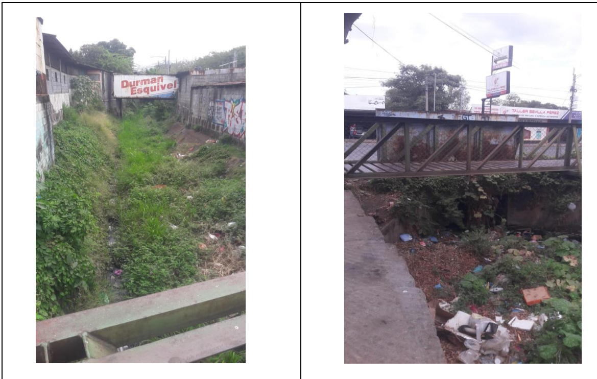
Imagen 2: Drenaje del tramo en estudio
