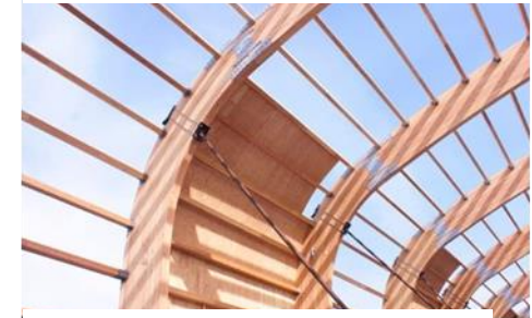
Figura 104 Estructura de madera
