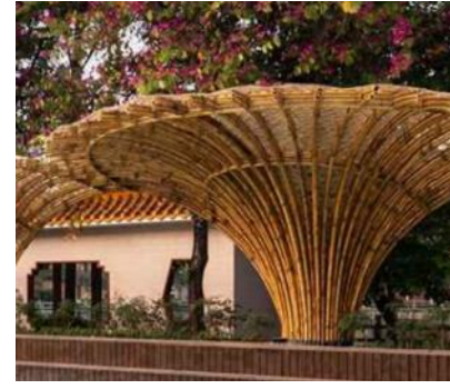
Figura 208 Estructura de bambú
