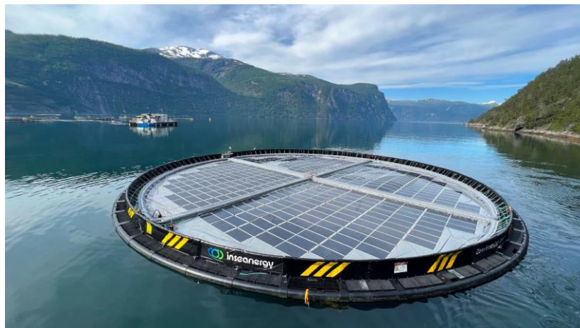
Bilde 3: Solcellepanel kan leggjast på gamle oppdrettsmerder. Flytande solenergi er foreløpig mest utbreidd i skjerma område og på ferskvatn-reservoar. Foto: Inseenergy.
