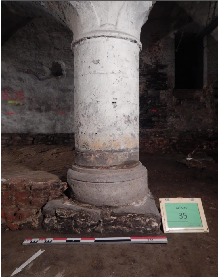
Figuur 14. Detailopname van een geprofileerde zuilbasis (S30)
