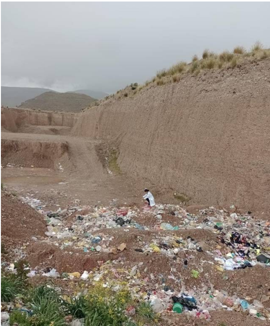
Figura 07: Inexistencia de impermeabilización en el botadero
