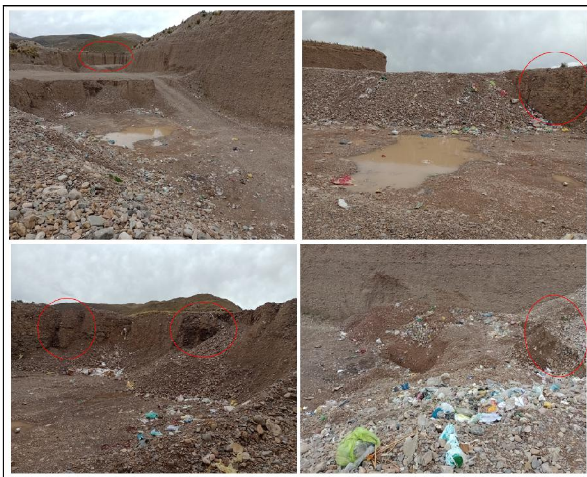
Figura 03: Afloramiento de Lixiviados en el perímetro del botadero
