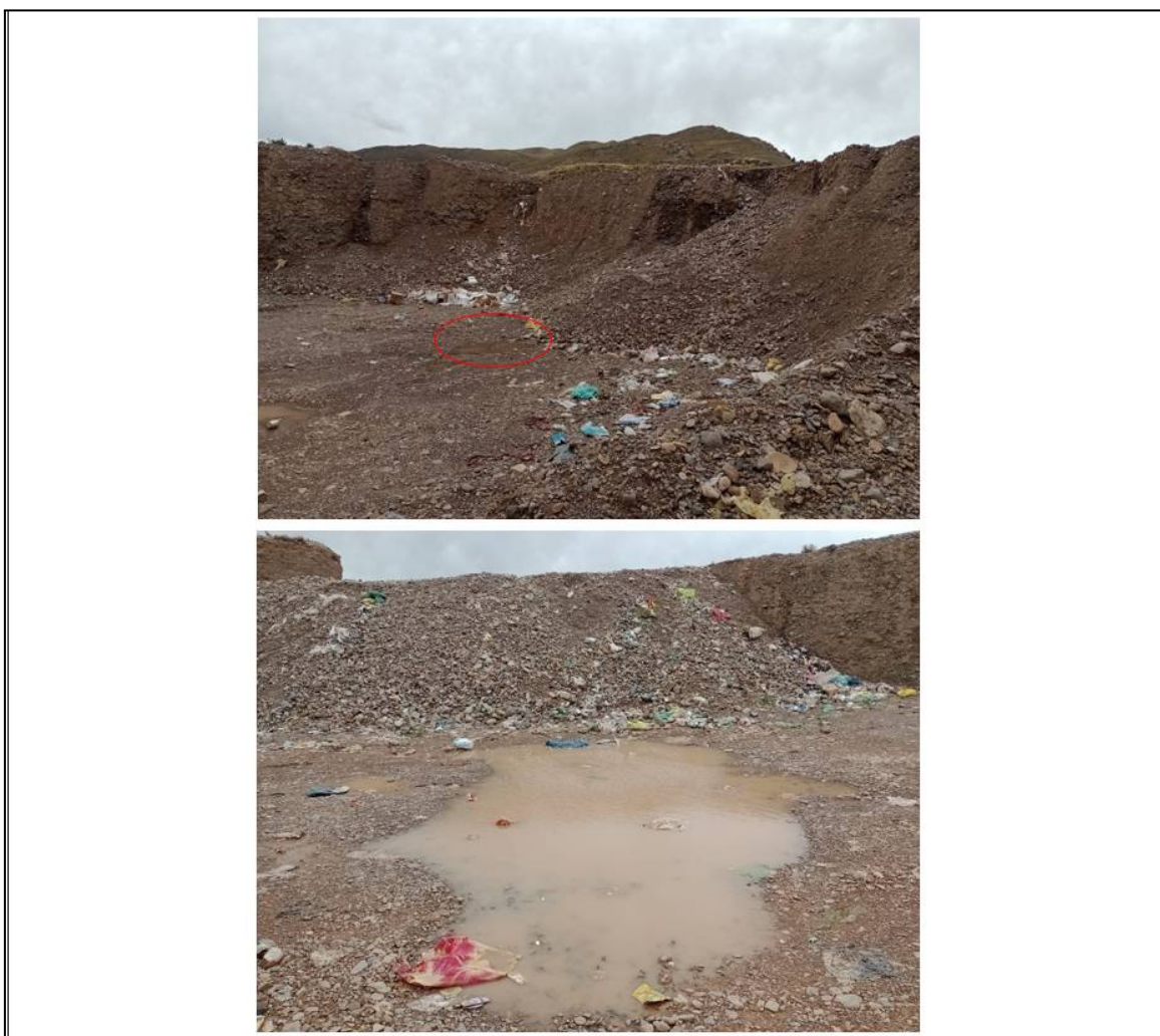
Figura 04: Afloramiento de Lixiviados en el pie del talud interno del botadero
