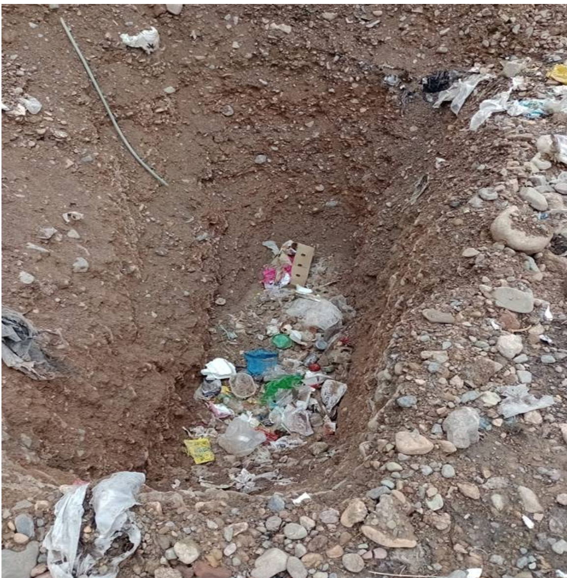
Figura 08: Inexistencia de una red de drenaje subsuperficial
