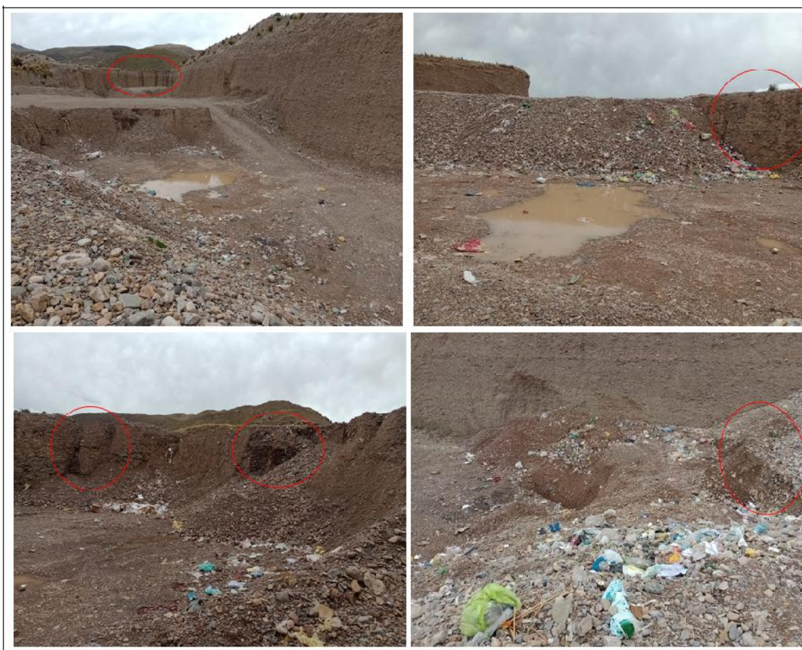
Figura 05: Afloramiento de Lixiviados laterales como flujo superficial del botadero
