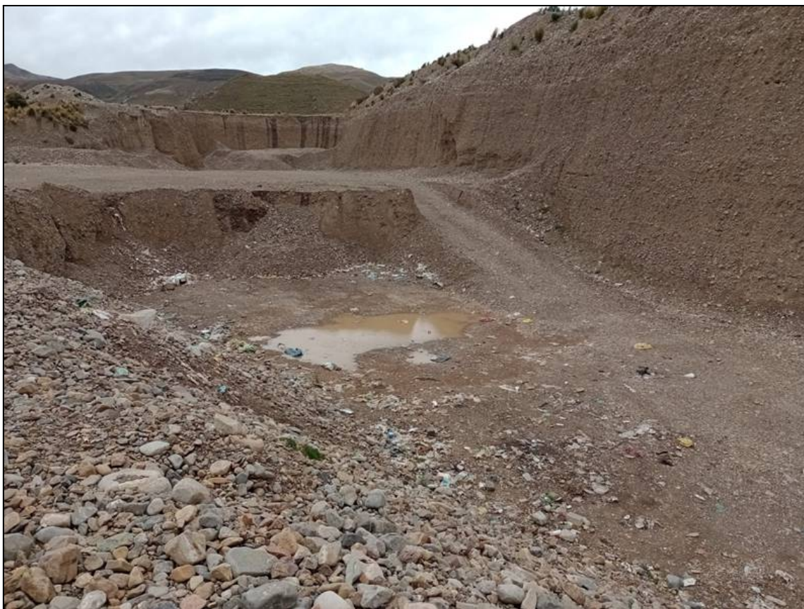
Figura 09: Inexistencia del sistema de evacuación de lixiviados.
