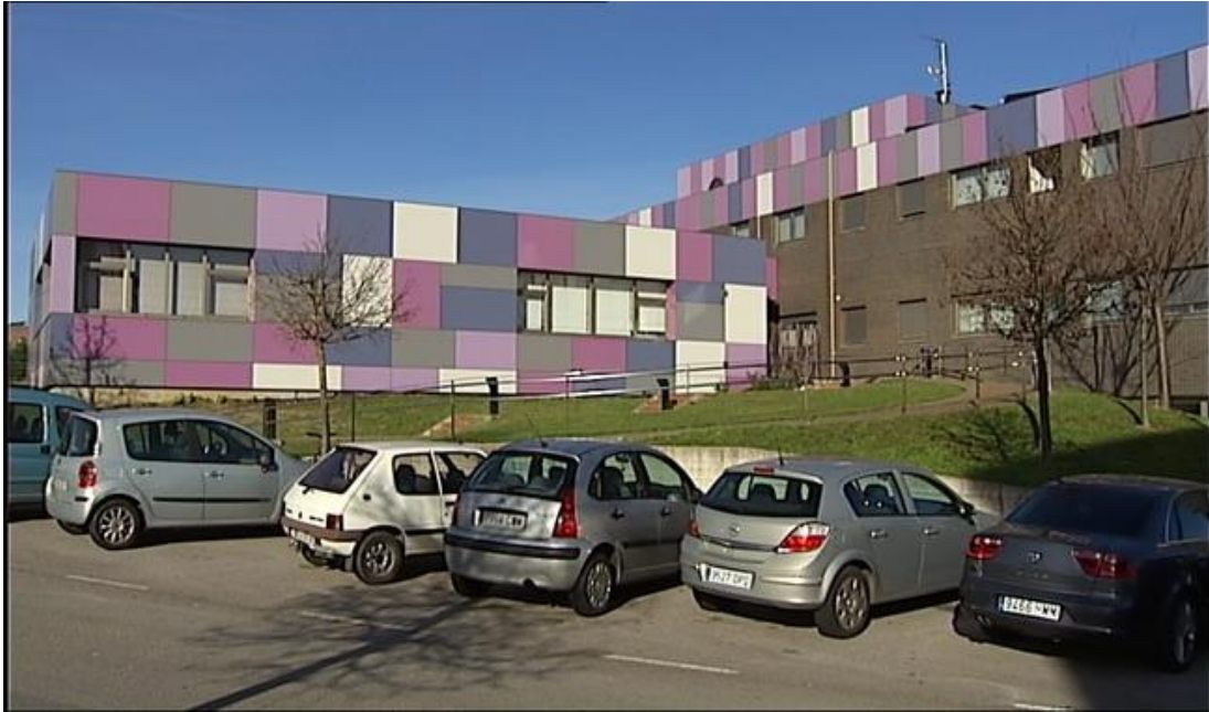
Figura 13. Volumetría desde el exterior, Casa Malva Fuente: Archdaily
